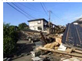
熊本地震の被害状況
