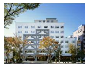
県内の耐震改修工事の事例
