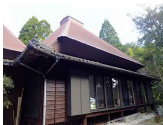
写真 12 既存屋根 (茅葺) の金属板葺
