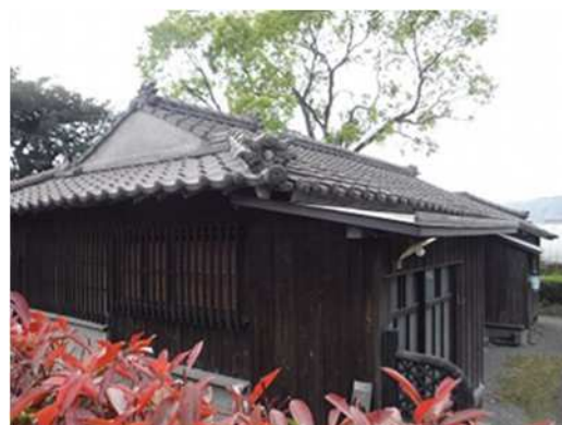
写真 10 下屋 (玄関) の金属板葺き
