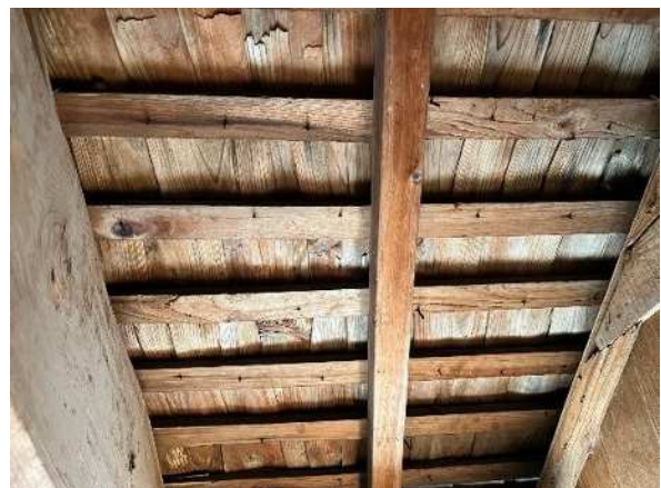
写真6 平木張りの材料および施工事例
