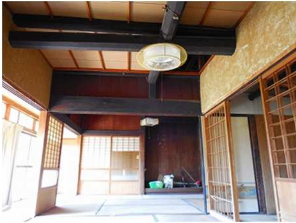
写真 13 構造材（梁・桁）の古材使用事例
