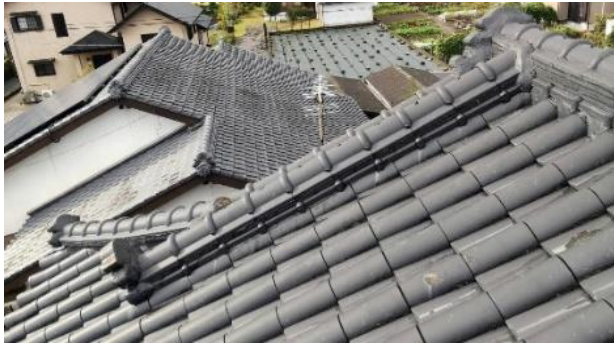
写真 9 勾配屋根の和瓦葺き
