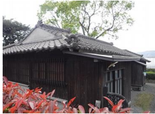
写真 10 下屋 (玄関) の金属板葺き
