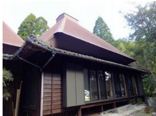
写真 12 既存屋根 (茅葺き) の金属板葺き
