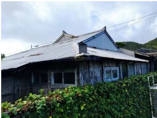
写真 11 熊毛地区以南における全面金属板葺き
