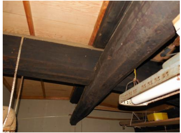
写真 13 構造材（梁・桁）の古材使用事例
