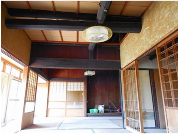
写真 13 構造材（梁・桁）の古材使用事例
