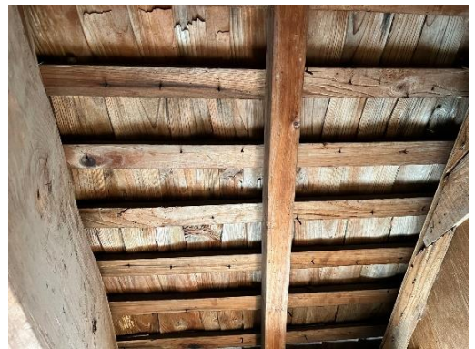
写真6 平木張りの材料および施工事例
