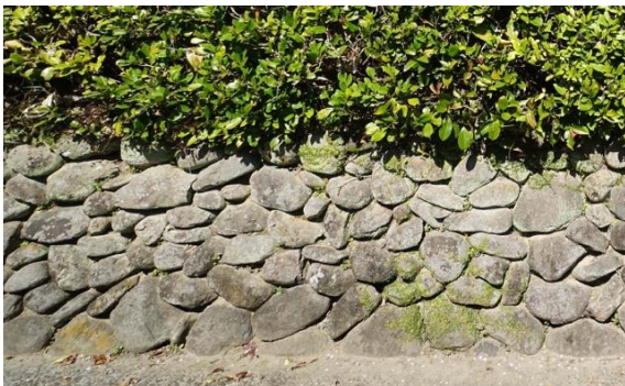
写真 17 野石積みの石垣
