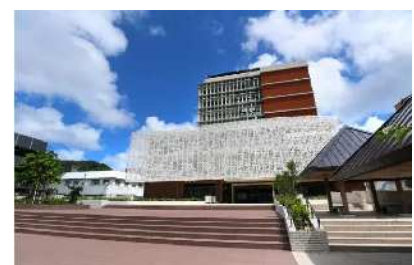
《奄美市役所(除却・建替工事実施)》
