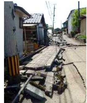
《大阪北部を震源とする地震の被災状況》
