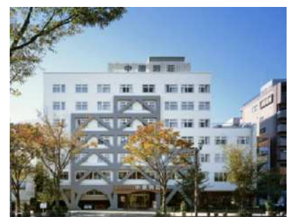
《県内の耐震改修工事の事例》
