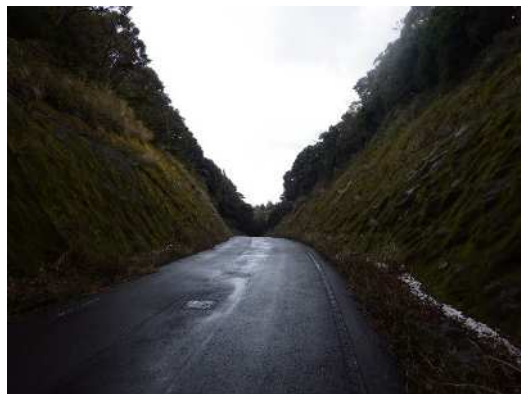
⑧勾配の大きい箇所の道路は切通しになっている。
