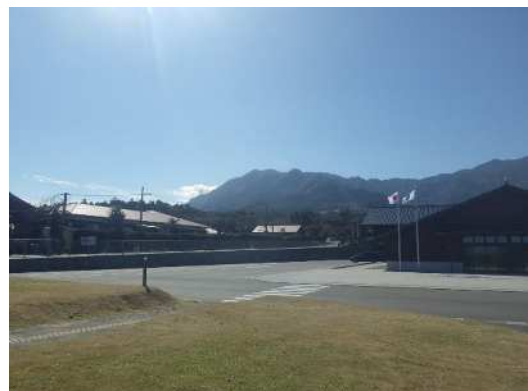
⑯屋久島町役場。海成段丘のなだらかな平坦面から奥に急峻な山地の様子。
