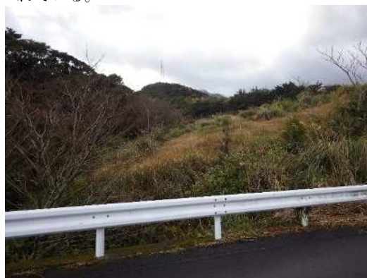
④段丘崖傾斜部分からの視点。傾斜の様子が視認出来る。
