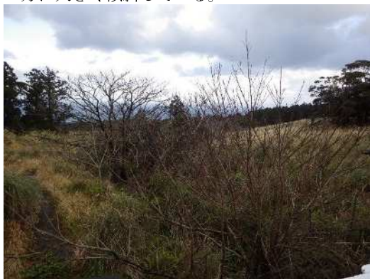
⑤段丘崖傾斜部分。草木の繁茂により確認が困難なもの、傾斜の様子が視認。
