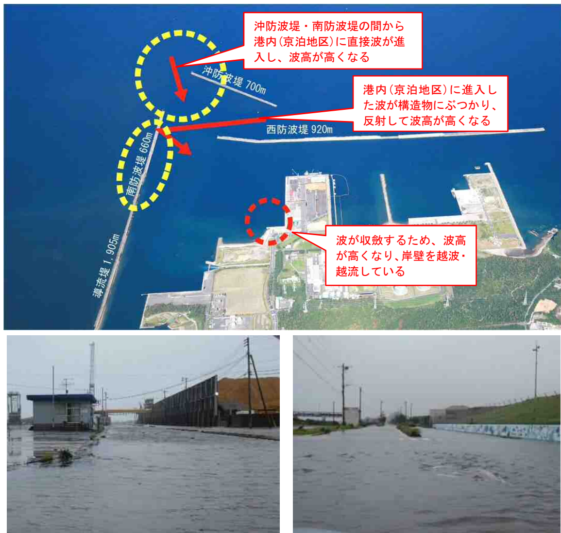
図 台風等による京泊地区の越波・越流被害
