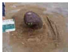
係船柱の発錆、沈下
