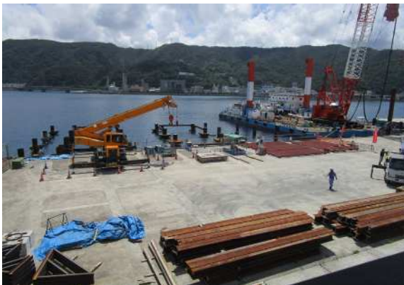
岸壁の整備状況
