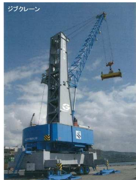
京泊地区 ジブクレーン
