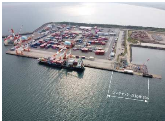
新若浜地区コンテナバース延伸整備状況
