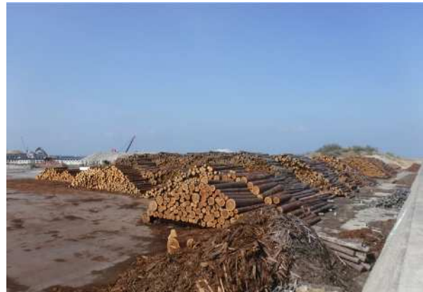
唐浜地区 原木仮置状況
