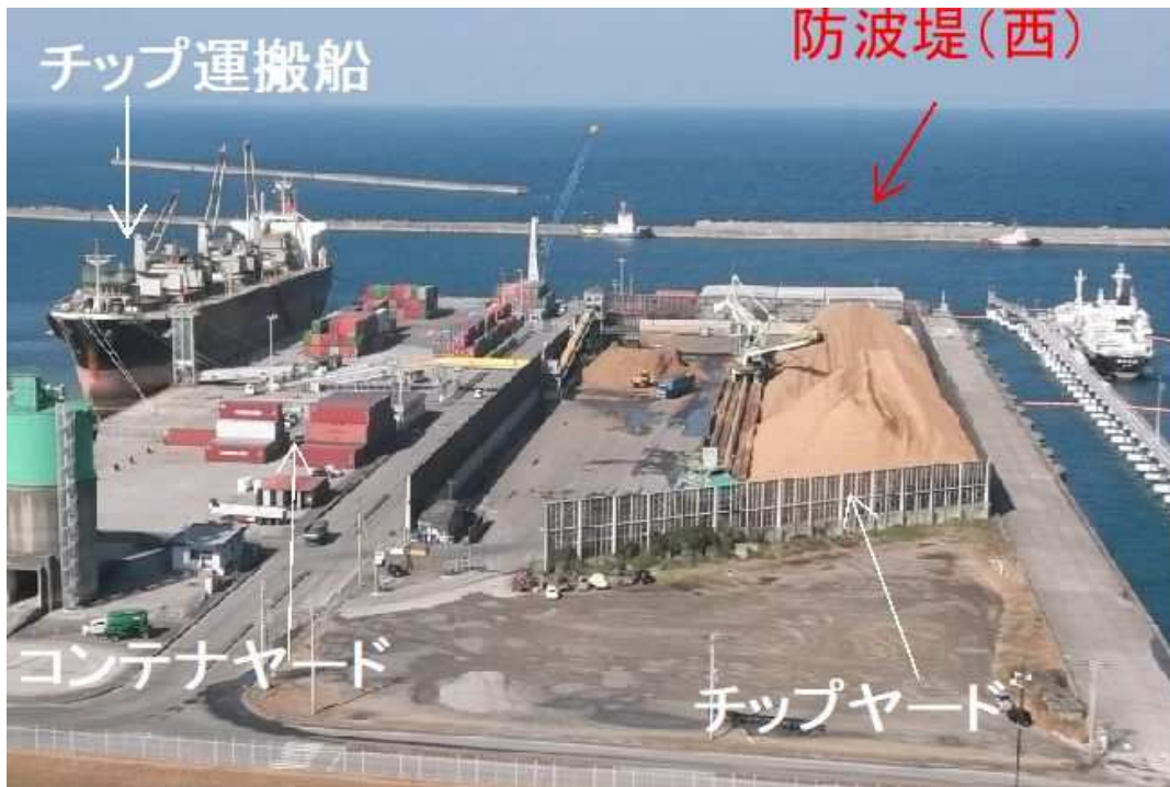
京泊地区 京泊ふ頭の利用状況
