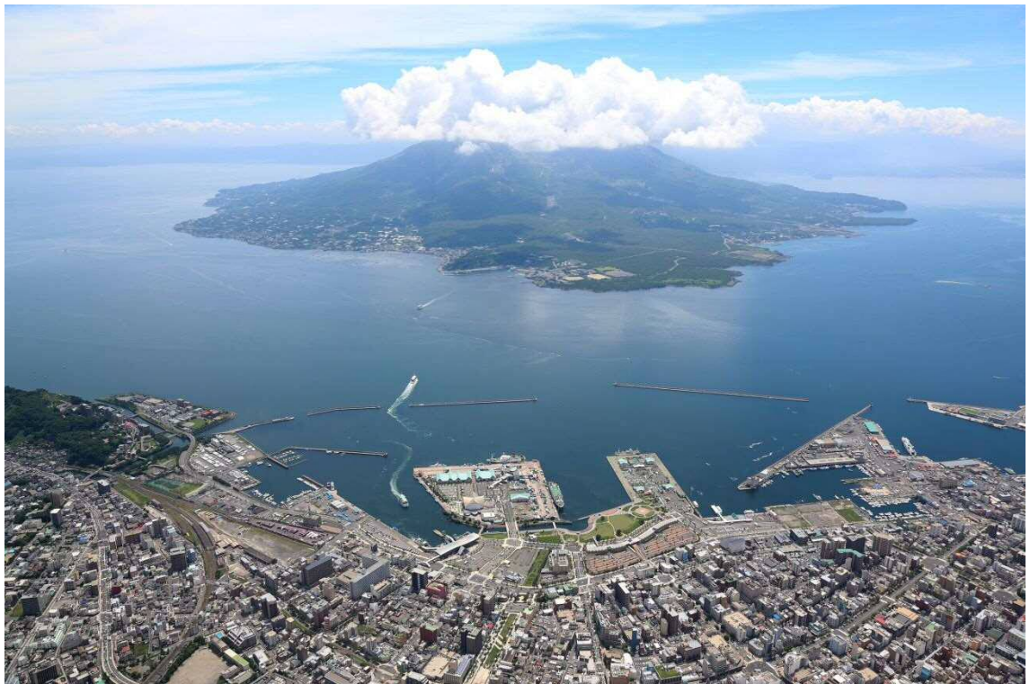
図 1-1 鹿児島港本港区周辺
