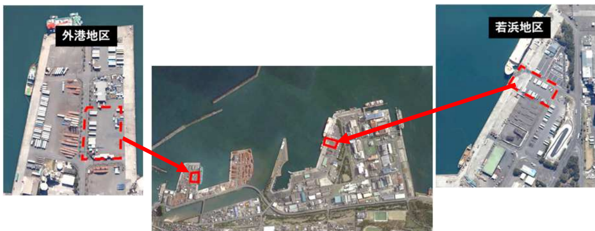
図 5-4 冷蔵・冷凍電源設備の位置
