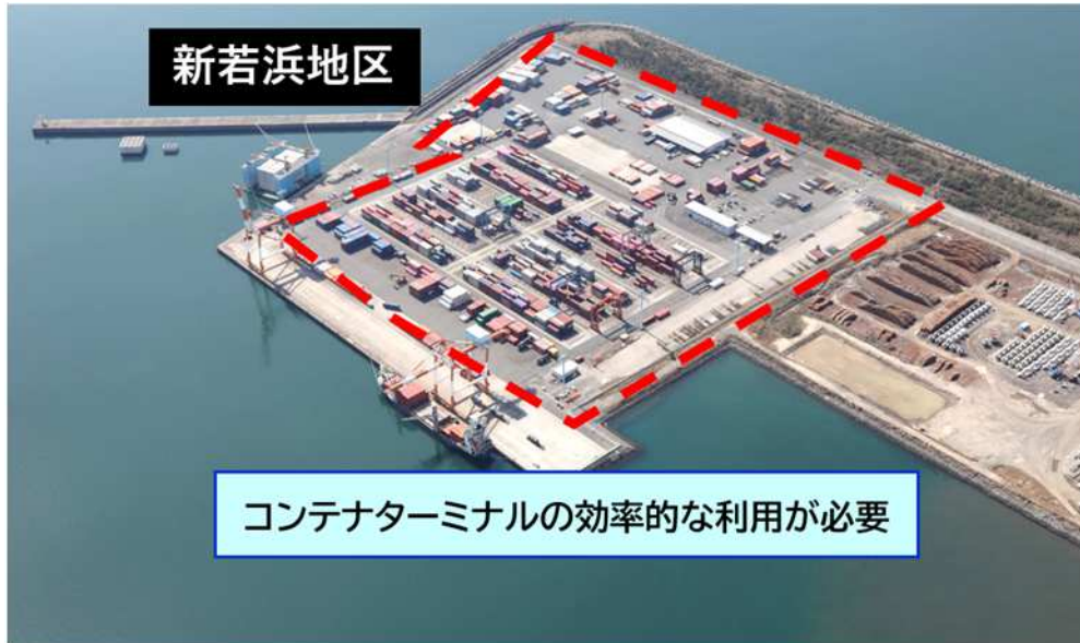
図 5-7 新若浜地区国際コンテナターミナルの利用状況
