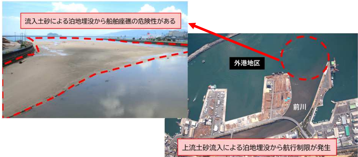
図 5-14 外港地区の泊地埋没の状況
