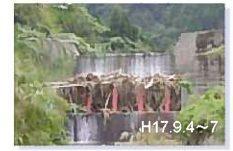
流木止め施設による流木捕捉工
