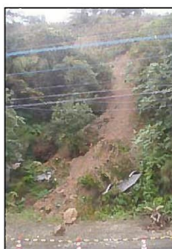
地すべり【奄美市 小浜】 被害なし (H21.11.13)
