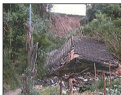
がけ崩れ【指宿市 尾掛】 倉庫全壊 (H21.6.28)
