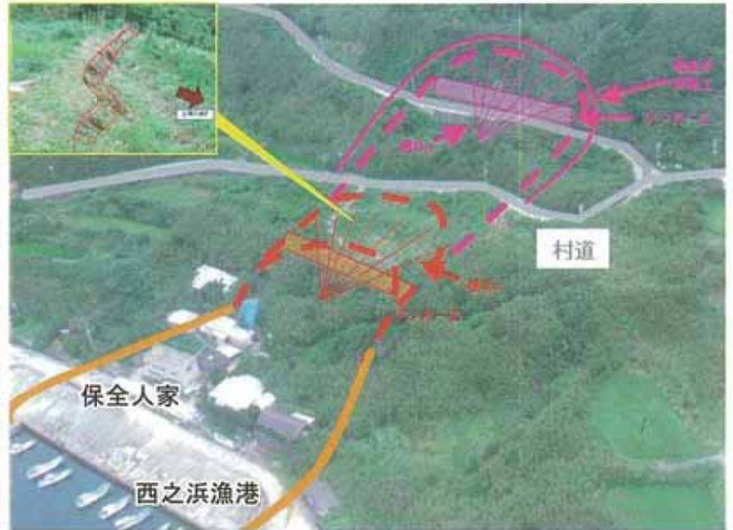
災害関連緊急地すべり対策事業(十島村口之島地区)
