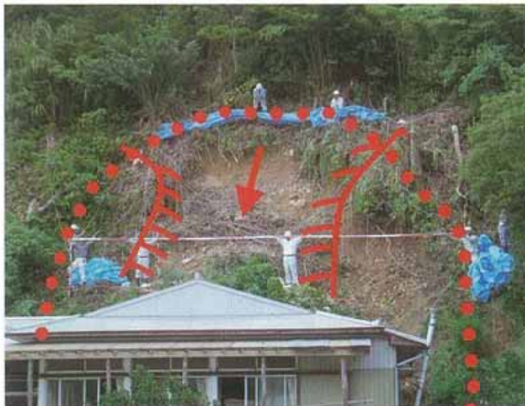
災害関連緊急急傾斜地崩壊対策事業(龍郷町中勝3地区)
