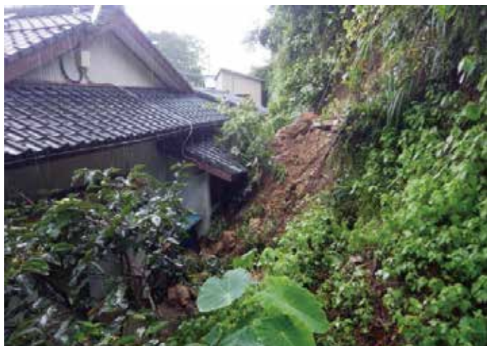
阿久根市脇本地内 八郷地区で発生したかけ崩れ（令和3年8月）
