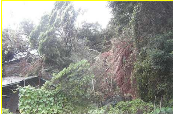
出水市高尾野町野口地区で発生したがけ崩れ(令和2年7月)
