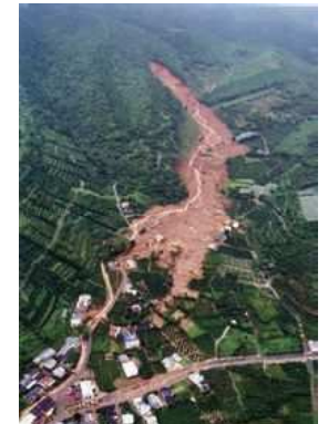
写真-5 平成9年針原川被害状況
