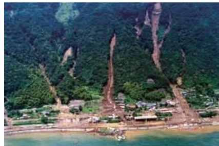
写真-2 平成5年竜ヶ水地区被害状況
