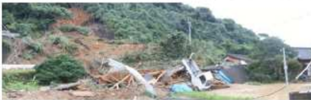
白木1地区(肝付町)がけ崩れ災害
