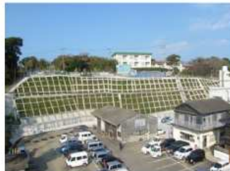
急傾斜地崩壊対策工事
