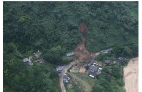
肝付町白木地内 がけ崩れ
