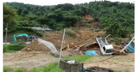
肝付町白木地内 がけ崩れ被害状況
