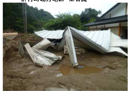
肝付町北方地区 土石流被害状況
