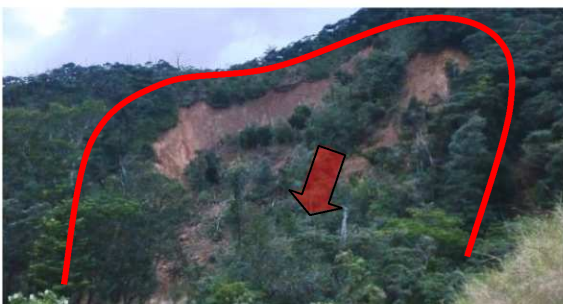
大島郡瀬戸内町西阿室地区(地すべり)
