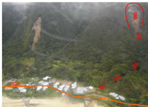
大島郡龍郷町加世間沢(土石流)
