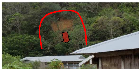
大島郡瀬戸内町三浦地区(がけ崩れ)
