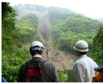
現地調査(根占山本地区)
