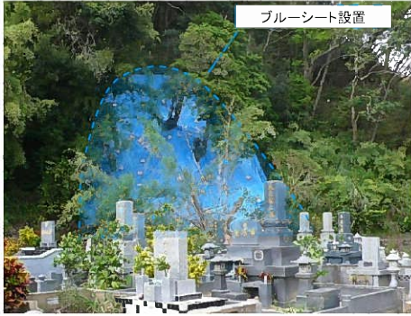
加世間沢(龍郷町加世間)大型土嚢設置・ブルーシート設置
