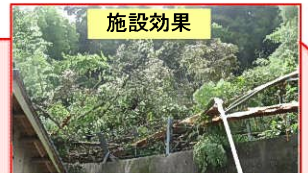
施設効果 落石防護柵が流木を受け止めている
