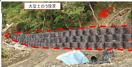
加世間沢(龍郷町加世間)大型土嚢設置・ブルーシート設置
