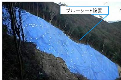
加世間沢(龍郷町加世間)大型土嚢設置・ブルーシート設置
