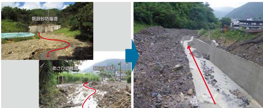
埋塞した流路工の除石
