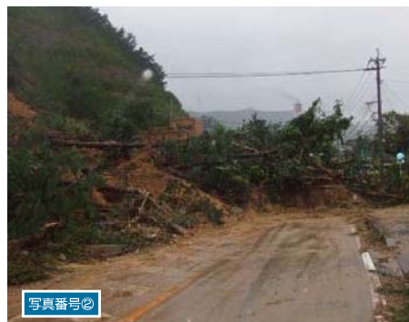
国道被災状況
