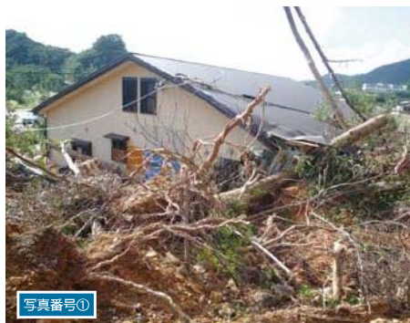
人家被災状況
