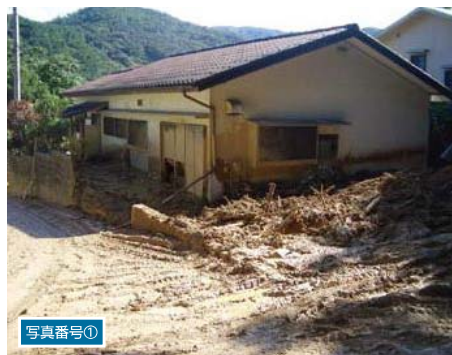
人家被災状況
