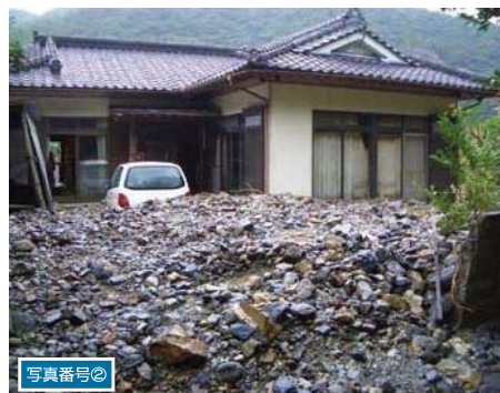
人家被災状況
