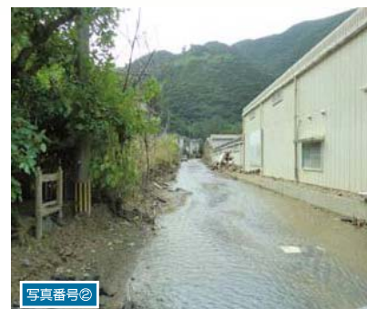
土砂流出状況
