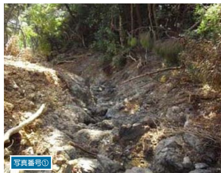
山腹崩壊状況
