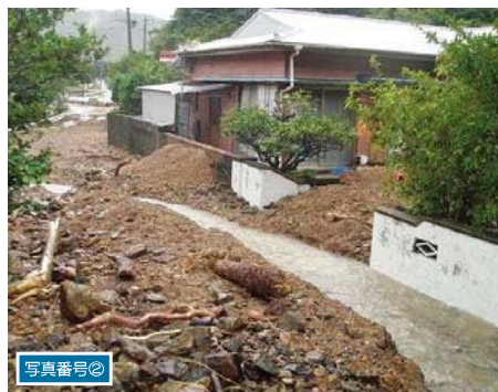
土砂流出状況
