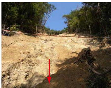
山腹崩壊状況
