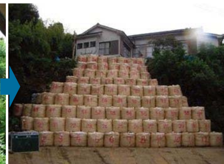
大型土のうによる応急工事
