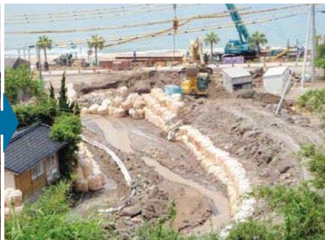
下流部流路工の大型土のう(護岸の高上げ)
