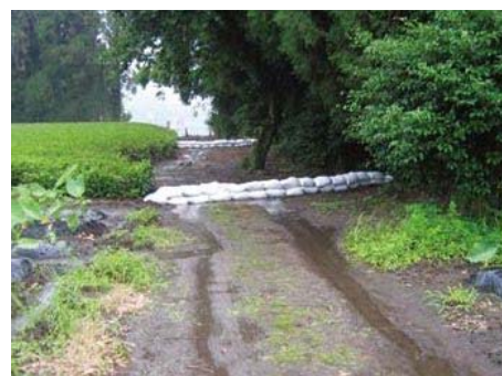
土のう設置による水切り
