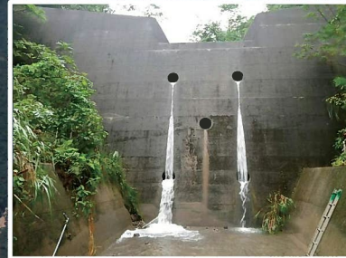
土石流捕捉後の既設砂防堰堤
