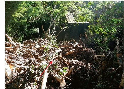
流木の捕捉状況
