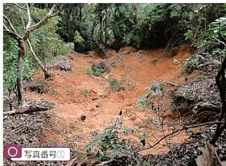
斜面崩壊状況
