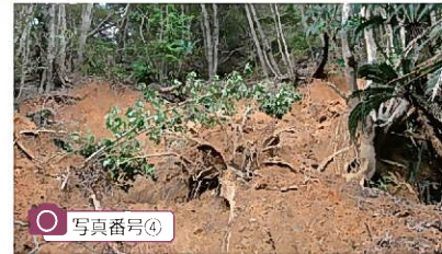
土砂流出状況
