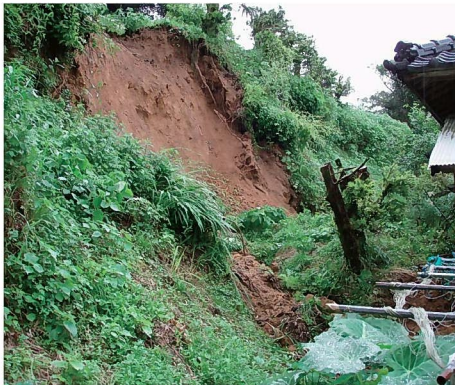
がけ崩れ(薩摩川内市山田下地区)6月16日発生 住家一部破損 1戸
