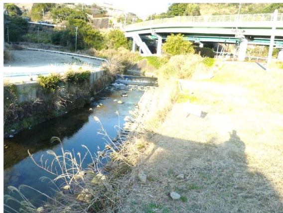
■放水路分水予定地点付近の状況
