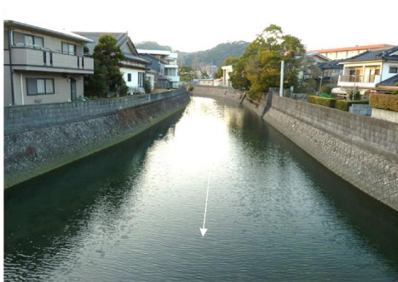
■ 国道戸柱橋より上流の状況
