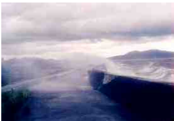
越波による被害1(出水市)
