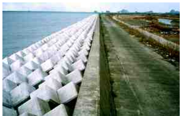
堤防(消波工)(金剛海岸)
