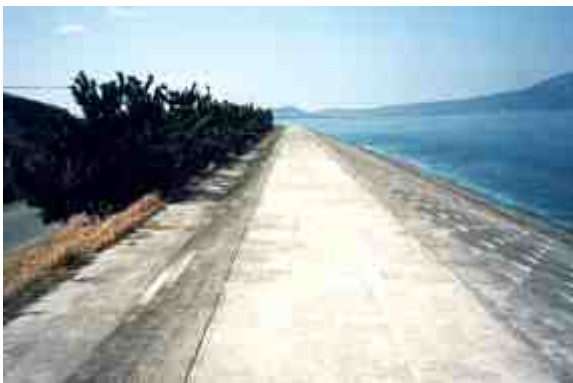
緩傾斜護岸と松林(出水海岸)
