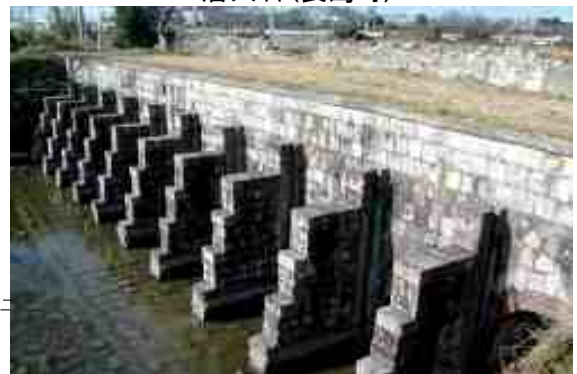
旧郡築新地甲号樋門(八代市)
