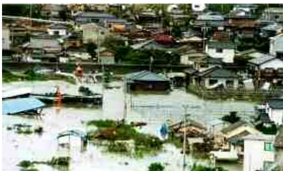
浸水による被害(宇城市不知火町)
