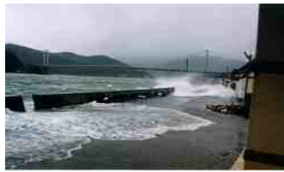
越波による被害(上天草市龍ヶ岳町)
