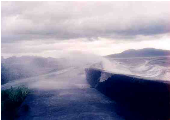
越波による被害1 (出水市)
