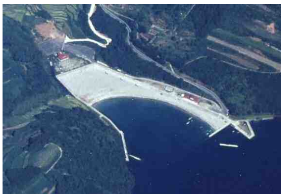
海岸環境整備事業(長島町海岸松ヶ平地区)
