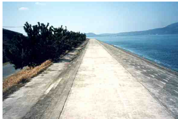
緩傾斜護岸と松林(出水海岸)
