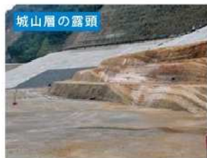
ダムの基礎岩盤である城山層が出現しました。当該箇所では護岸を設置せずに城山層を露頭させたまま残しました。
