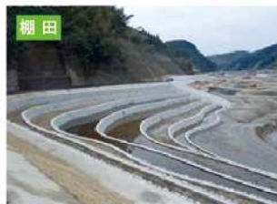
西之谷地区の里山風景を再生するため棚田を整備しました。
