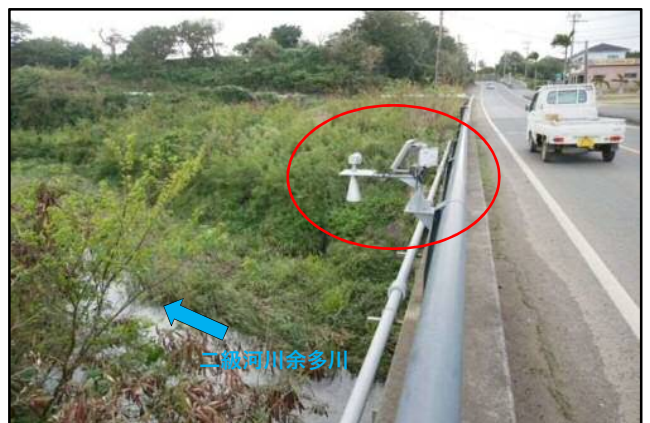
危機管理型水位計（設置状況）
