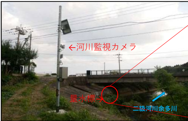
量水標②（天竜橋真下付近 左岸）
