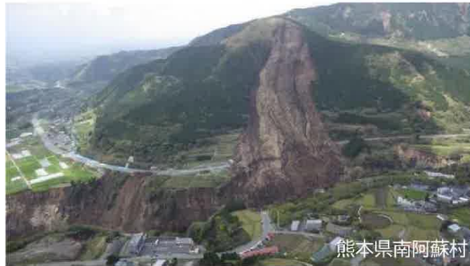
図 2-5 道路の被災リスク（法面崩壊） 7)
