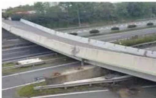
九州自動車道をまたぐロックンゲ橋脚の落橋 （県道小川嘉島線・府領第一橋）
