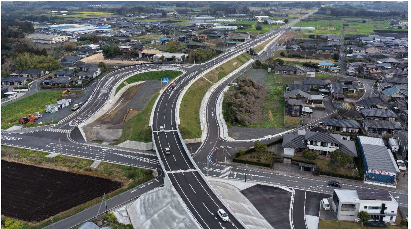
大隅縦貫道 吾平道路（鹿屋市）
