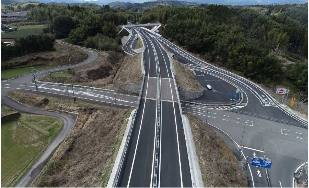
地域高規格道路 北薩横断道路(さつま広橋IC付近)
