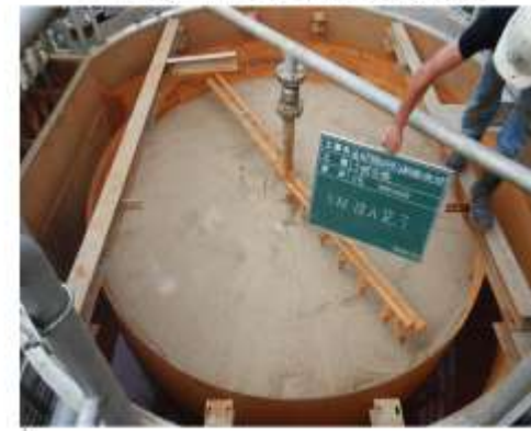
処理装置内ろ過材の交換状況
