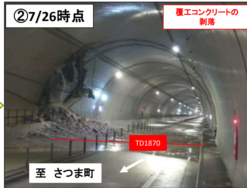
同地点 覆工コンクリート剥落 延長約6~7m
