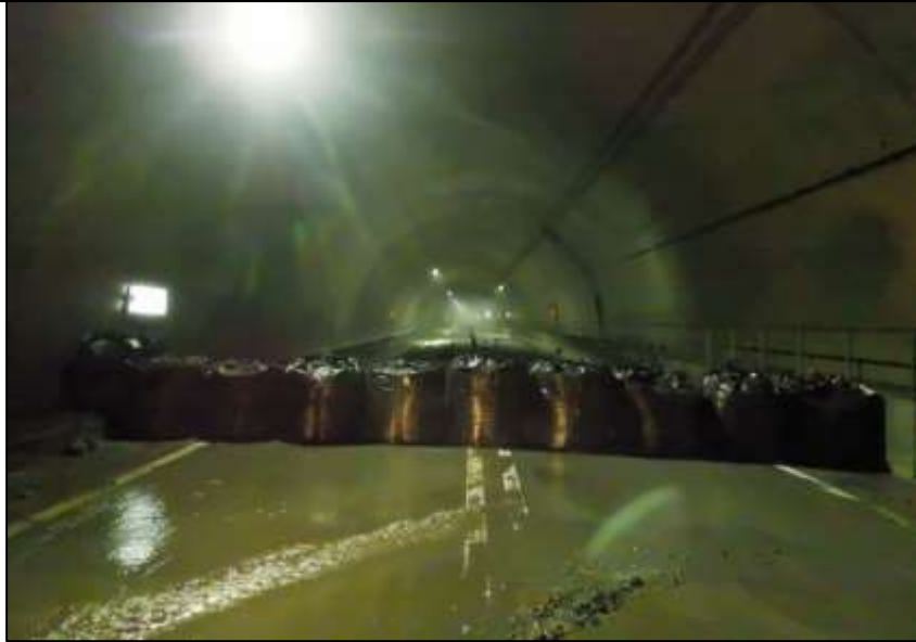
土砂流出防止堤(出水市側坑口より1460m地点)
