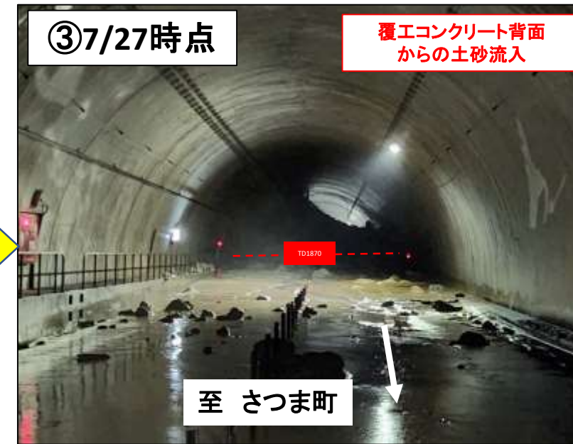
同地点 トンネル背面から土砂が流出
