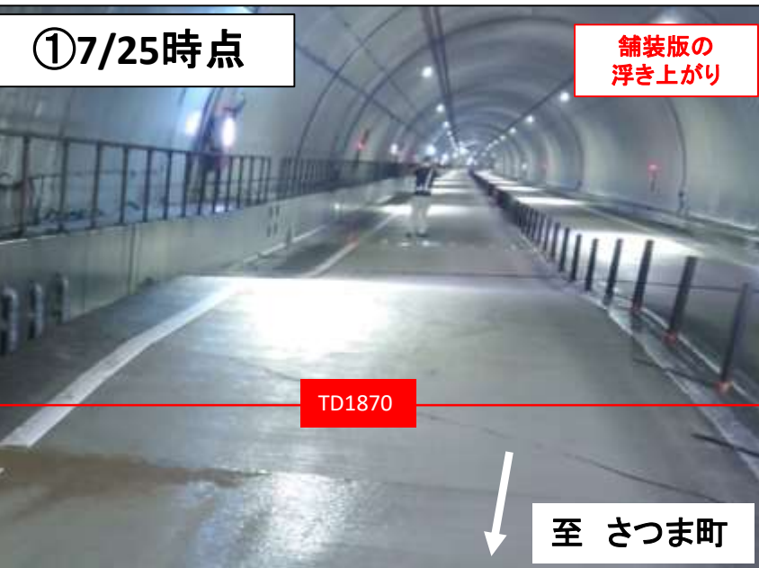
出水側坑口より1,870m地点（出水方面車線） 舗装版の浮き上がり 延長約50m, 最大高0.4m
