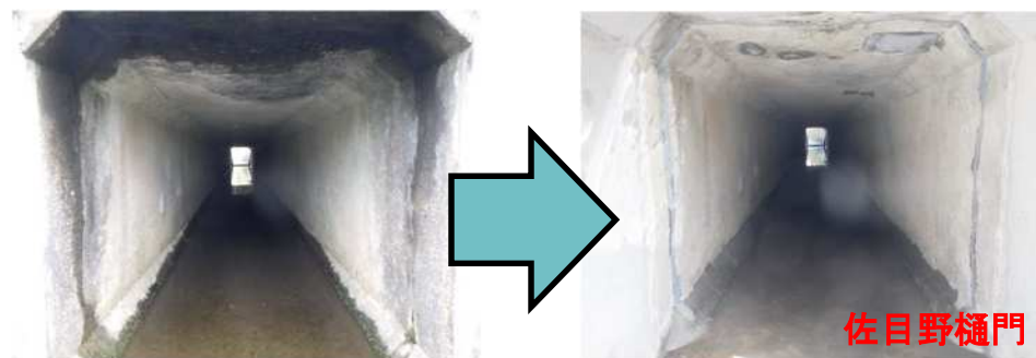
樋管内部のコンクリート補修
