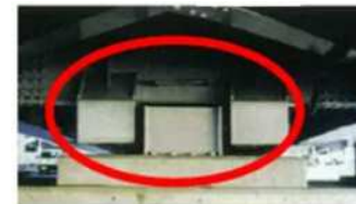
■対策完了により地震に強い橋へ
