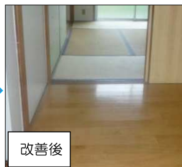
【板の間の段差解消状況】
