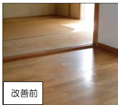
【板の間の段差解消状況】
