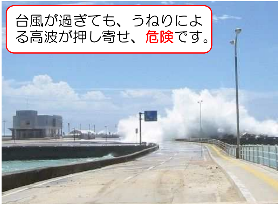
和泊港 防波堤(沖)(北) 延長400m
