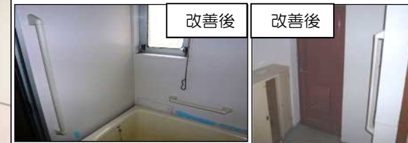
【浴室・玄関の手すり設置状況】
