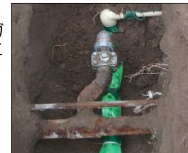
老朽化した埋設管
