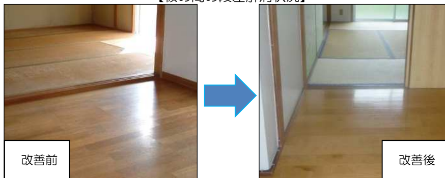
【板の間の段差解消状況】
