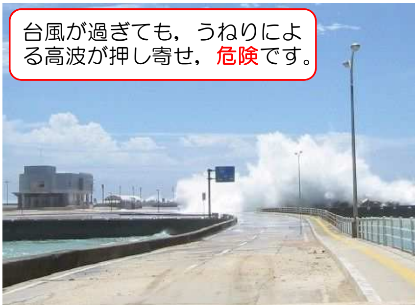
和泊港 防波堤(沖)(北) 延長400m
