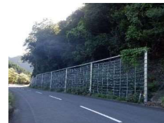
■道路斜面の崩壊を未然に防ぐ 国道447号 上大川内工区
