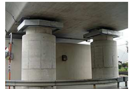
【橋脚の巻立て】
