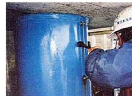
腐食した鋼材を防食材で表面被覆し延命化
