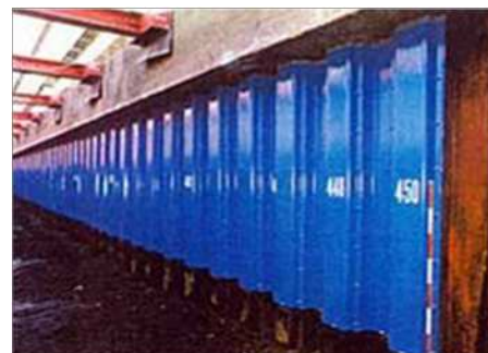
腐食した鋼材を防食材で表面被覆し延命化
