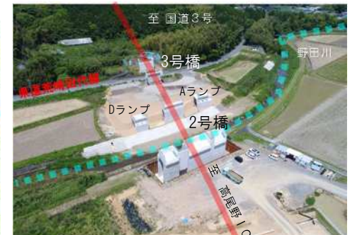
((仮)野田南IC付近)
