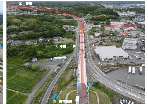
(終点側より起点側を望む)
