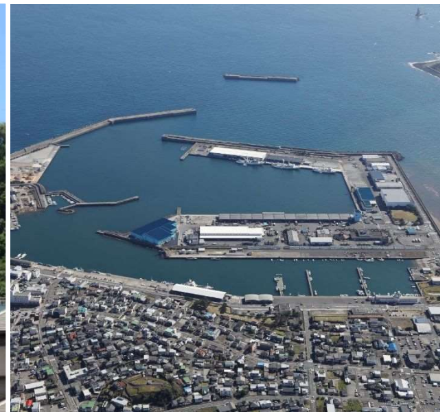
■「農林水産業の「稼ぐ力」の向上に資する生産基盤づくり」 を図る事業 漁港施設の整備（写真：枕崎市・枕崎漁港）
