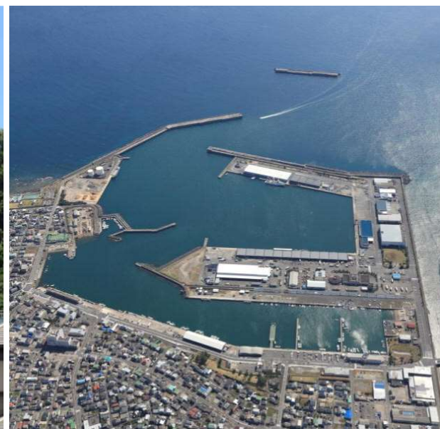
■「農林水産業の「稼ぐ力」の向上に資する生産基盤づくり」 を図る事業 漁港施設の整備（写真：枕崎市・枕崎港）
