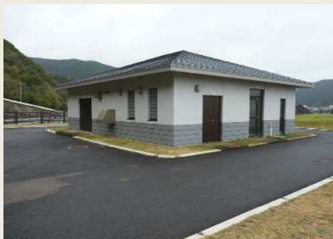
汚水処理施設（大和村 東部地区）
