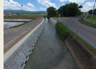
生態系保全水路の整備 (出水西部地区: 出水市)
