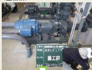
【中原加圧機場（枕崎市） （整備前）
