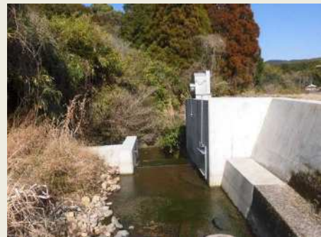
取水施設の整備（古里地区：薩摩川内市）
