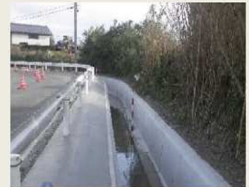
排水路の整備 (出水西部地区: 出水市)
