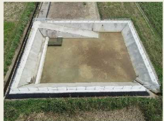
耕土流出防止のための沈砂池
