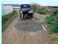
農道の路面補修
